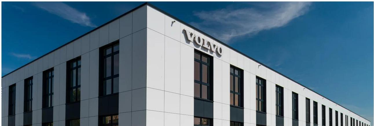
Rund 80 Meter lang und 27 Meter breit ist das Gebäude, das aus insgesamt 90 Raummodulen besteht. Nur 2 ½ Wochen dauerte die Montage der Module vor Ort – aufgeteilt in zwei Montageabschnitte. Bereits 3 ½ Monate später konnte das Gebäude dem Bauherrn übergeben werden. Statisch ist der zweigeschossige Bau für die Aufstockung um ein weiteres Geschoss gleicher Nutzung ausgelegt. EG und OG sind dabei in weiten Teilen identisch aufgebaut.
