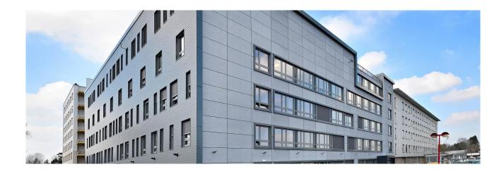
Aufgrund stetig steigender Anforderungen an das Krankenhaus in Mons "CHU Ambroise Paré" bestand die Notwendigkeit, einen neuen Gebäudeflügel auf dem bestehenden Gelände zu errichten. Beeindruckend war die Modulmontage, bei der ein 70 Meter hoher und 100 Meter langer Kran die 220 vorgefertigten Module in kürzester Zeit aufstellte. Nach 50 Tagen Montage entstand ein neuer Gebäudeflügel mit einer Gesamtfläche von 10.000 Quadratmetern.
