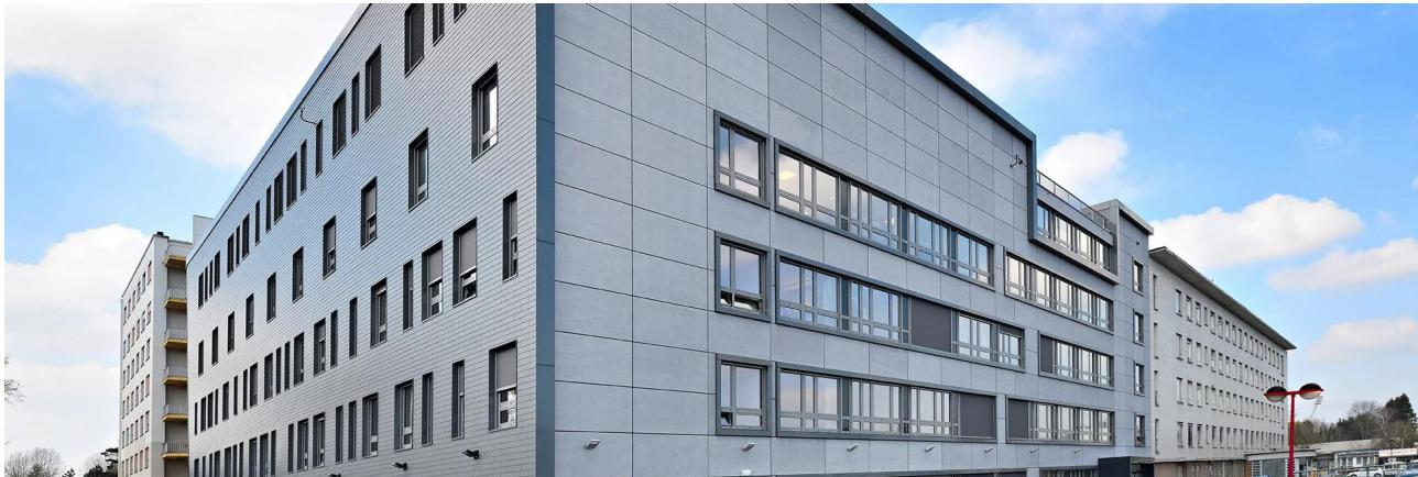
Aufgrund stetig steigender Anforderungen an das Krankenhaus in Mons „CHU Ambroise Paré“ bestand die Notwendigkeit, einen neuen Gebäudeflügel auf dem bestehenden Gelände zu errichten. Beeindruckend war die Modulmontage, bei der ein 70 Meter hoher und 100 Meter langer Kran die 220 vorgefertigten Module in kürzester Zeit aufstellte. Nach 50 Tagen Montage entstand ein neuer Gebäudeflügel mit einer Gesamtfläche von 10.000 Quadratmetern.
