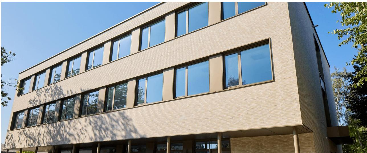
Um den steigenden Bedarf an Schulraum schnell zu decken, entschied sich die Stadt Bad Doberan für eine innovative Modulbauweise. Diese ermöglichte eine besonders schnelle Umsetzung des Projekts: Nach nur 16 Wochen Bauzeit vor Ort konnte das neue Grundschulgebäude in Betrieb genommen werden.
