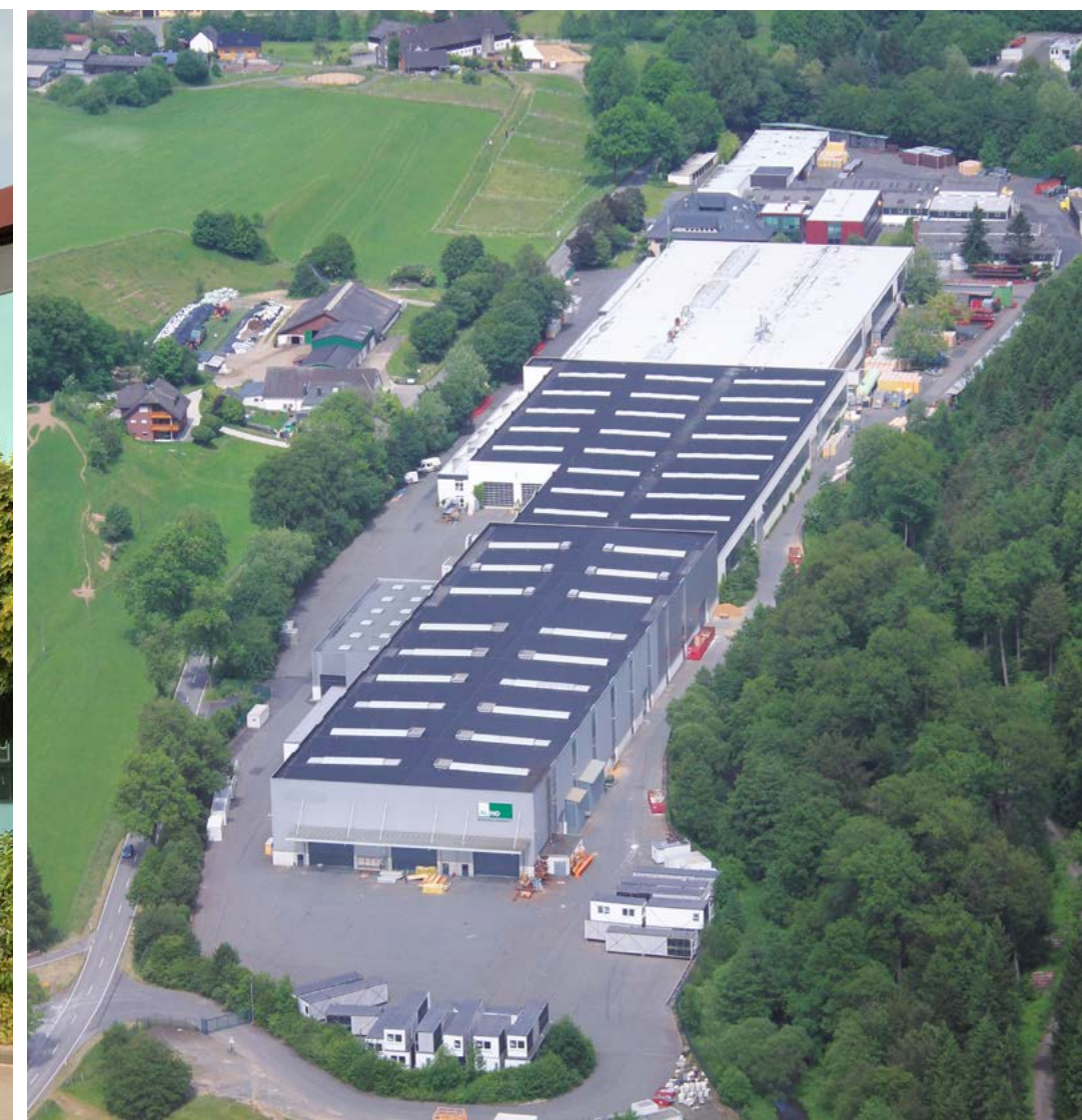
Kantoor- en productiegebouwen van ALHO in de vestiging van Morsbach
