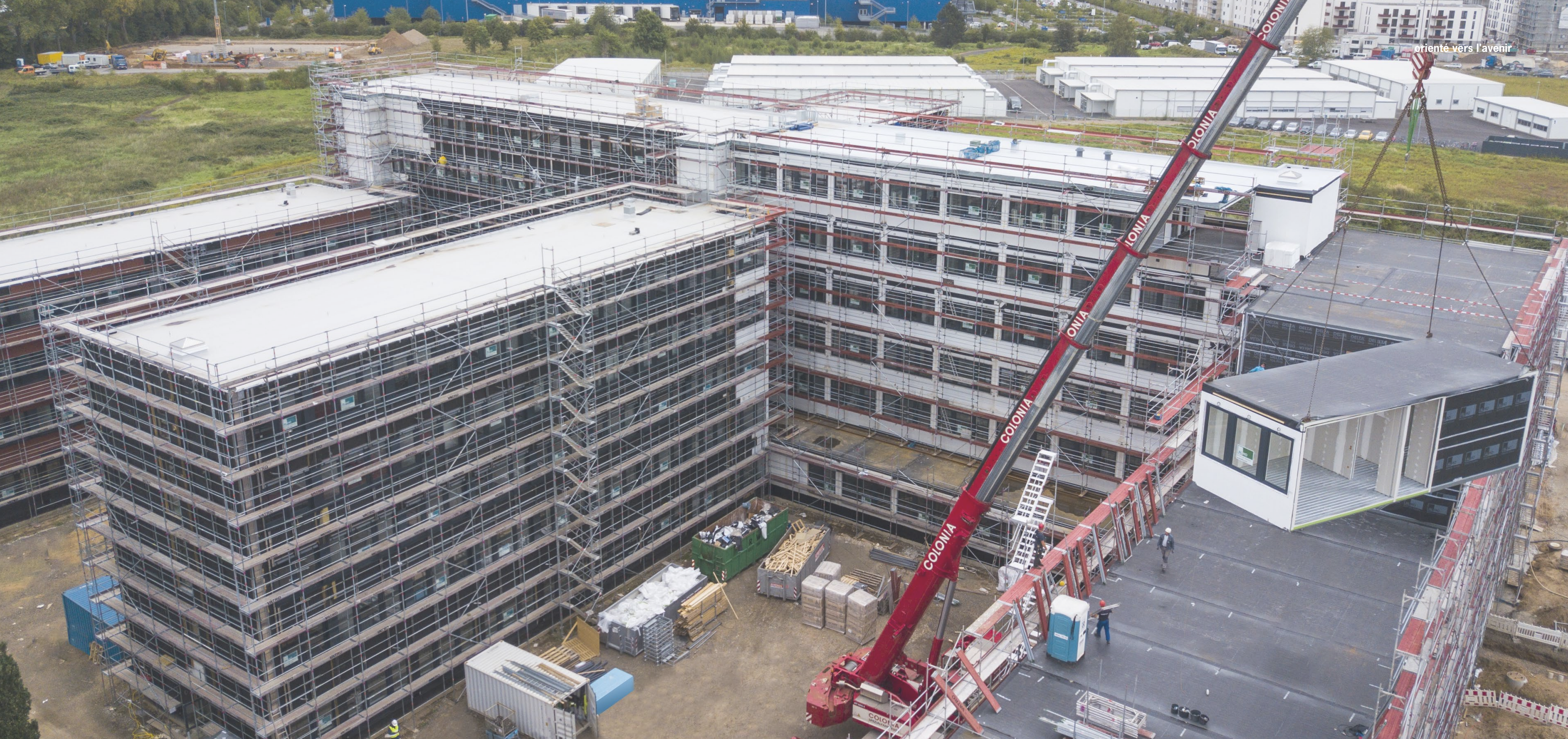
Le montage de modules pour l'Agence fédérale de l'emploi, agence pour l'emploi de Cologne
