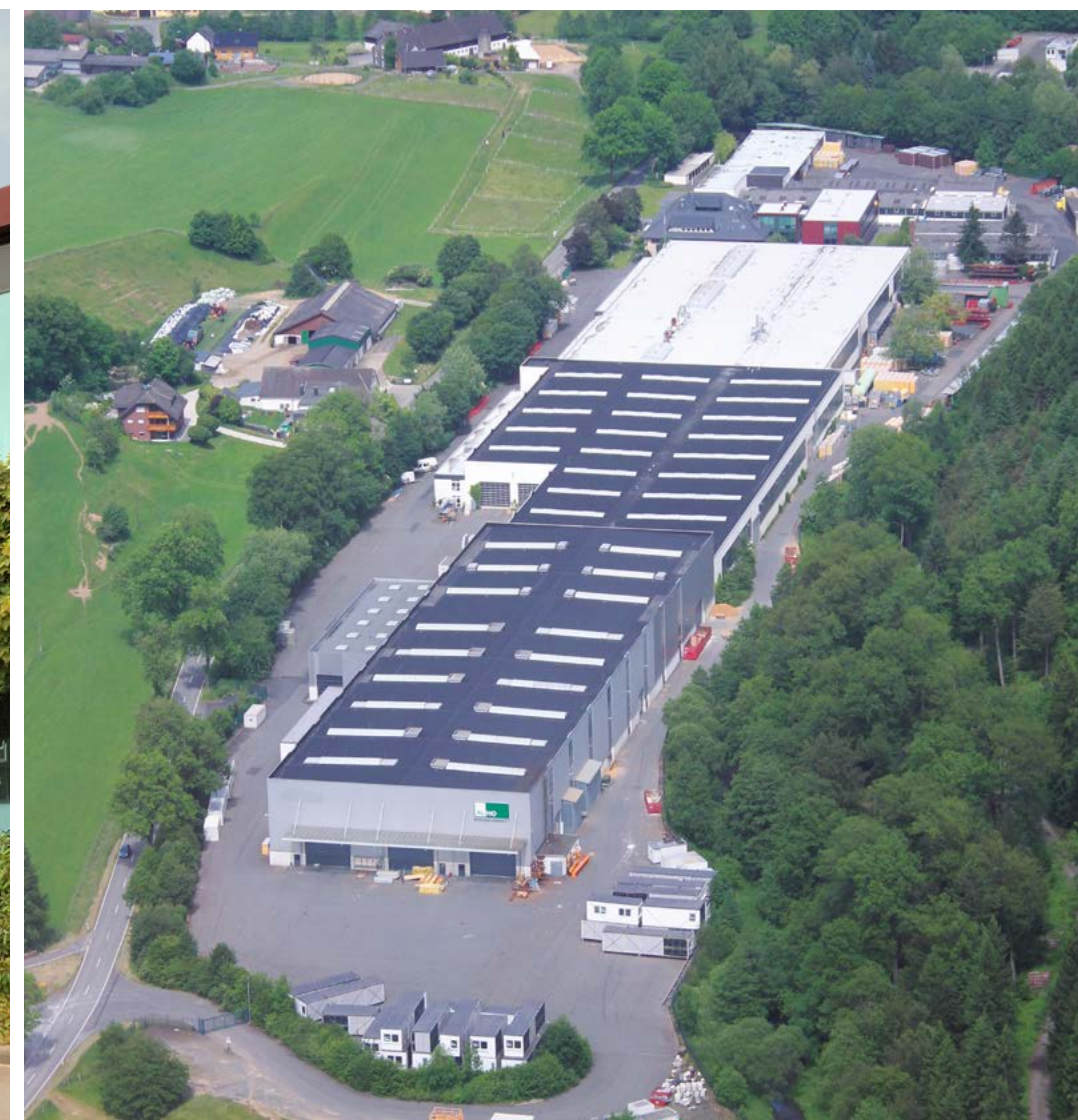
Bâtiments administratifs et production d'ALHO sur le site de Morsbach
