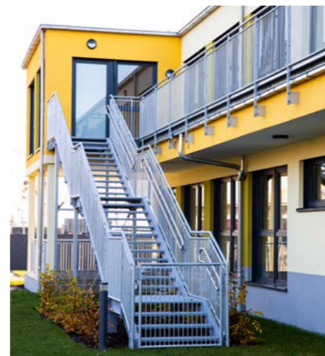
Les salles de groupe bien éclairées grâce à de grands espaces vitrés ont toutes un accès direct au jardin.
