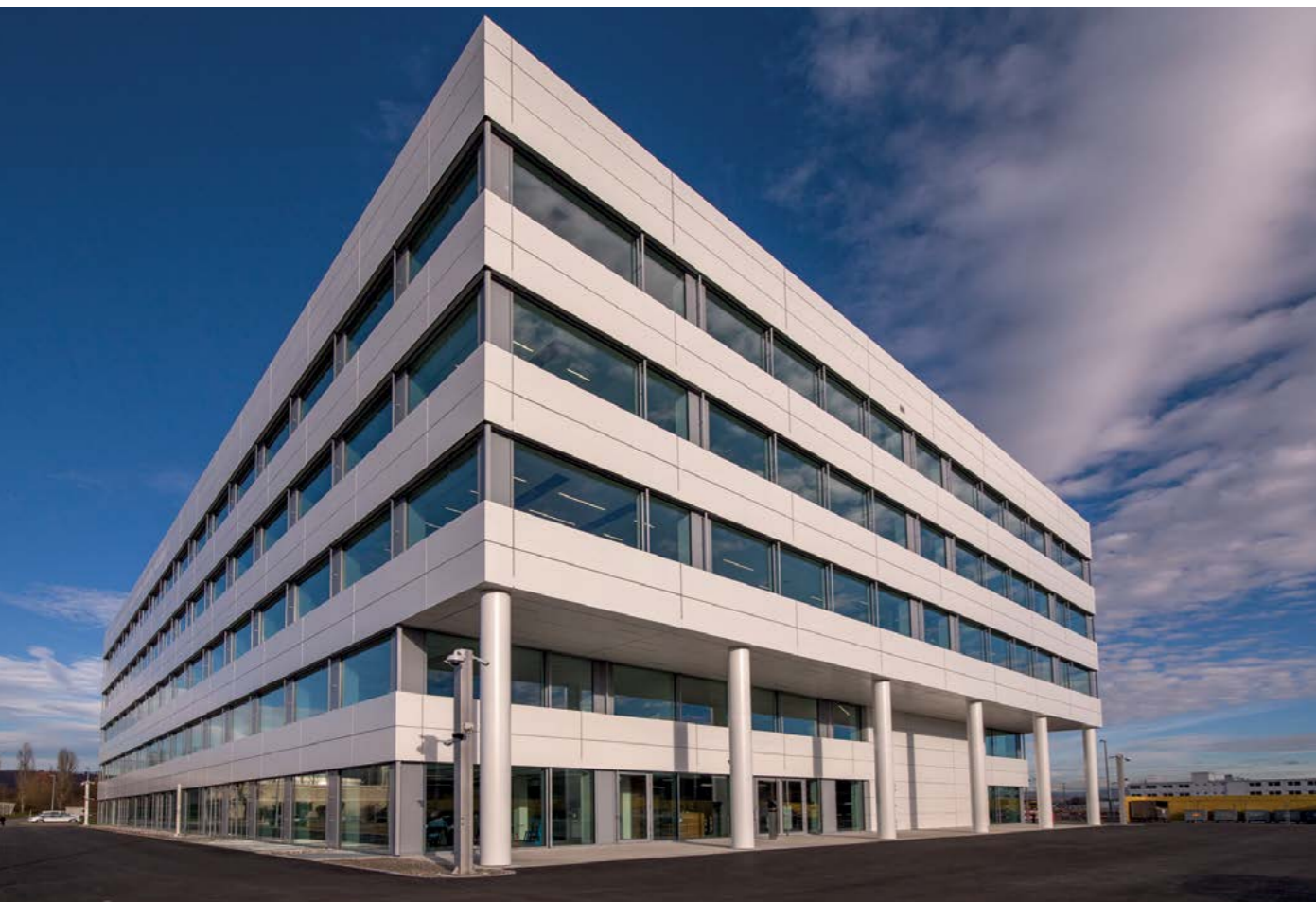
Le Roche Learning Center à Kaiseraugst près de Bâle réalisé par ALHO est le plus grand laboratoire d'Europe sous forme de bâtiment modulaire.
