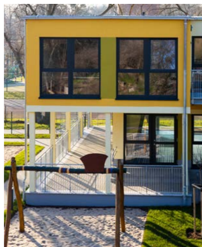
L'étage supérieur en porte-à-faux et sur châssis protège contre les intempéries.
