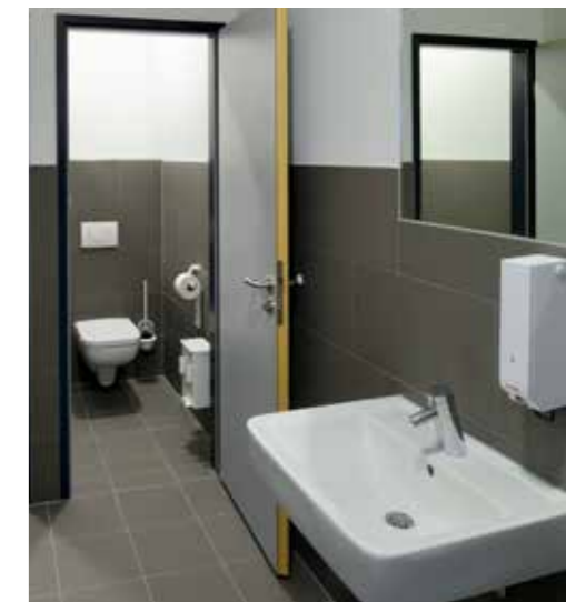
Sanitaires accessibles aux personnes à mobilité réduite
