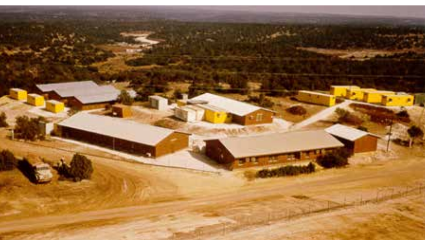
Grand chantier avec baraques en bois au Nigéria
