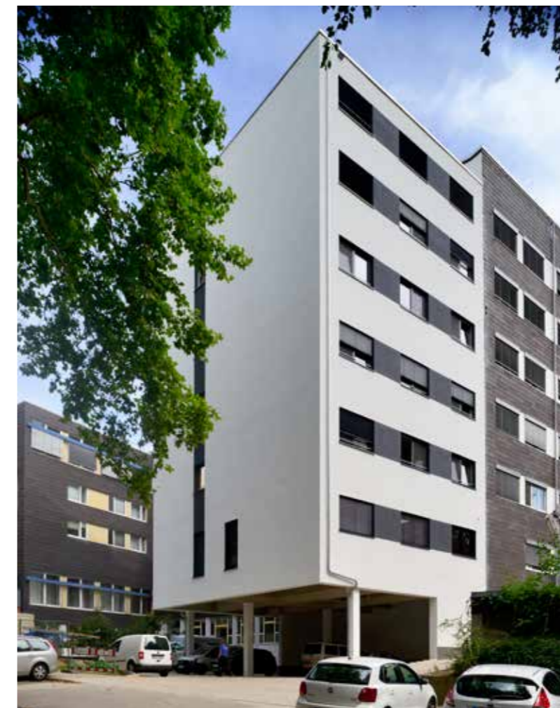
L'annexe de l'hôpital St Josef à Essen a été reliée au bâtiment existant via six étages.
