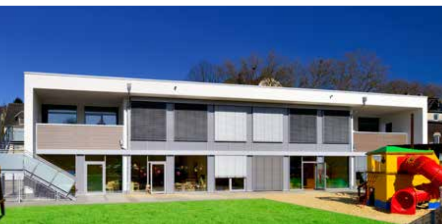
La crèche « Weingartenstraße » fait partie d'un lotissement construit selon les principes de la protection du climat
