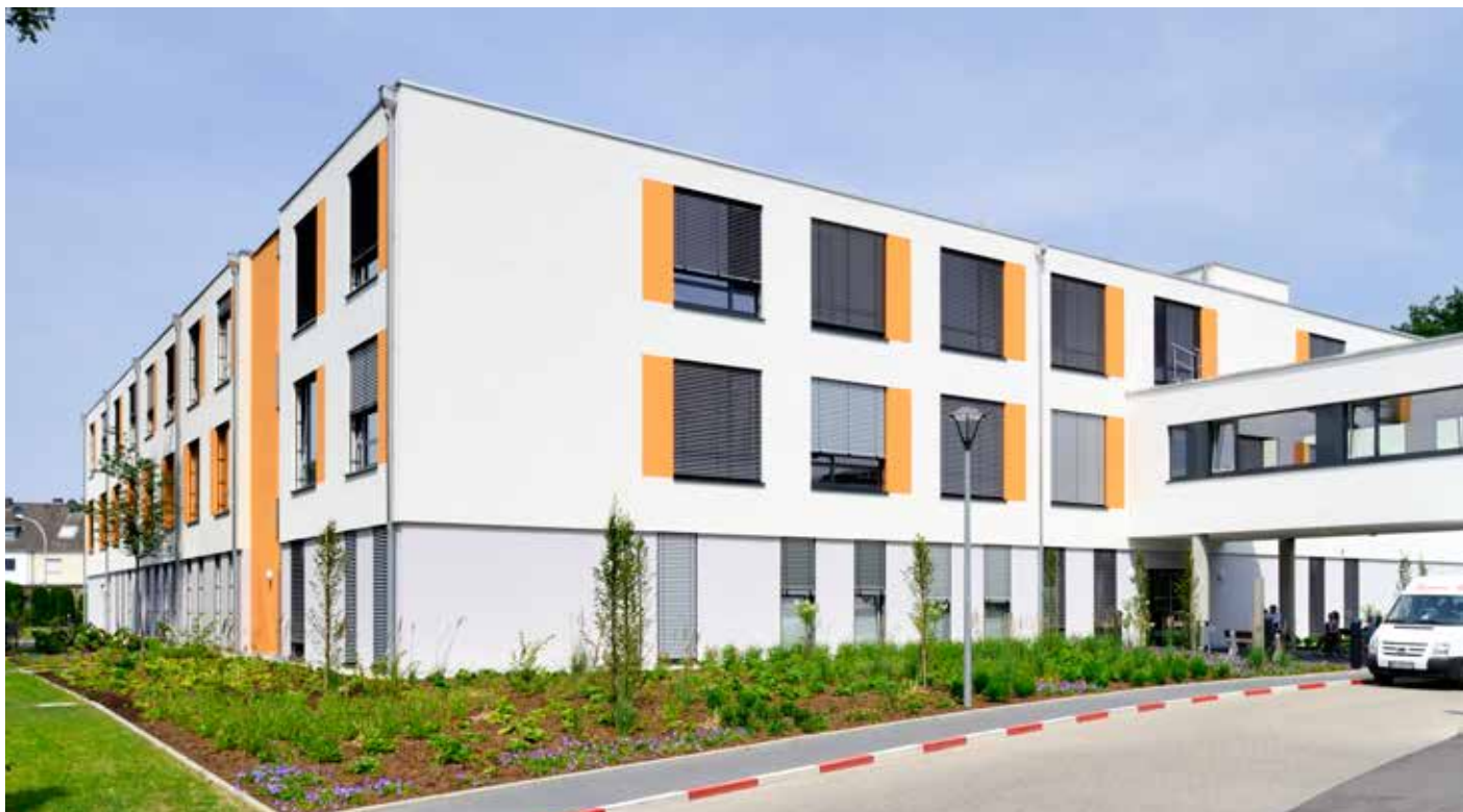
Le nouveau bâtiment du service de gériatrie vit le jour en 2012 en seulement 100 jours de construction sur place.
