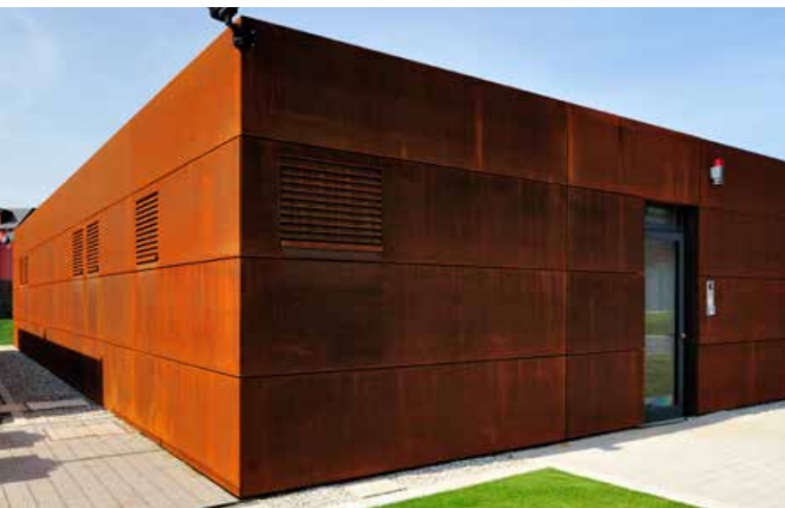
L'acier fait également bonne figure lors de l'aménagement des façades. BMS, Esch sur Alzette, Luxembourg
