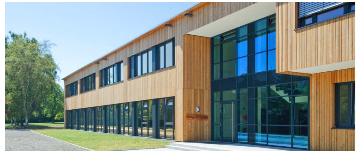
Am Seminargebäude der Forsthochschule Rottenburg wurden vorgehängte hinterlüftete Fassadenelemente aus Holz montiert.
