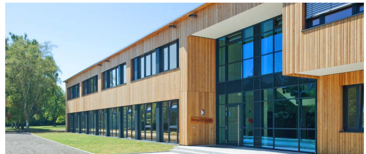
Dans le bâtiment des séminaires de l'école forestière de Rottenburg, des éléments de façade ventilés par l'arrière, de type rideau, ont été installés en bois.
